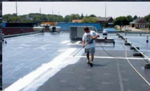
Applicering av primer och armering om så erfordras.
