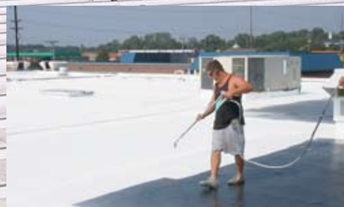
• Ett kraftigt, fogfritt och elastiskt tätskikt appliceras med sprayer.
