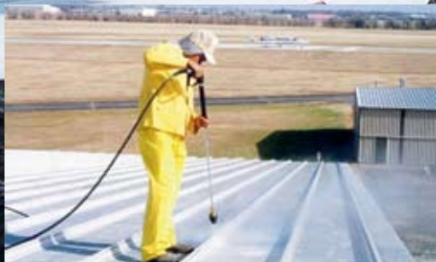
Noggrann rengöring före applicering av primer och tätskikt.
